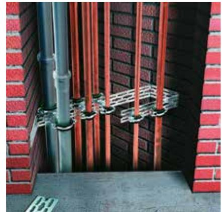
Montaje en bajantes: Conexión por ambos lados del perfil StaboFix® con abrazaderas M8 o M10 para tuberías paralelas
