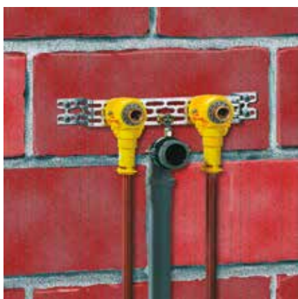
Instalación de lavabos: Instalaciones fijadas con exactitud
